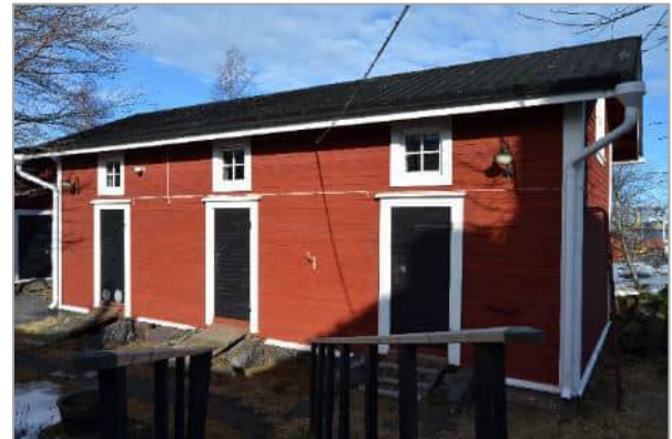
Kuva 30. Piharakennus kuvattuna pihan puolelta. Rakennuksessa on kolme sisäänkäyntiä, yläkerrassa on vuosien saatossa majoitettu mm. vierailuvia kilpapurjehtijoita. Kuvannut KT.
