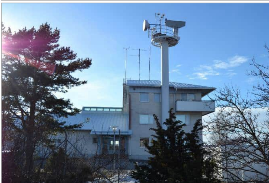
Kuva 43. Merivartioaseman alkuperäinen rakennusosa idästä. Matalamman rakennusosan katon harjalla on kattolyhty. Kuvannut KT.
