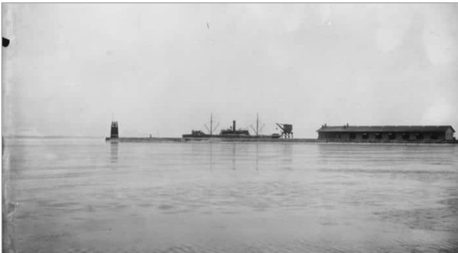
Kuva 12. Mäntyluodon satama kuvattuna Kallon suunnalta 1910–1920-luvulla. Satama-alueen aallonmurtajan kärjessä näkyy satamamajakaksi alun perin rakennettu Ryssäntorni. Kuva: Satakunnan Museon kokoelma.
