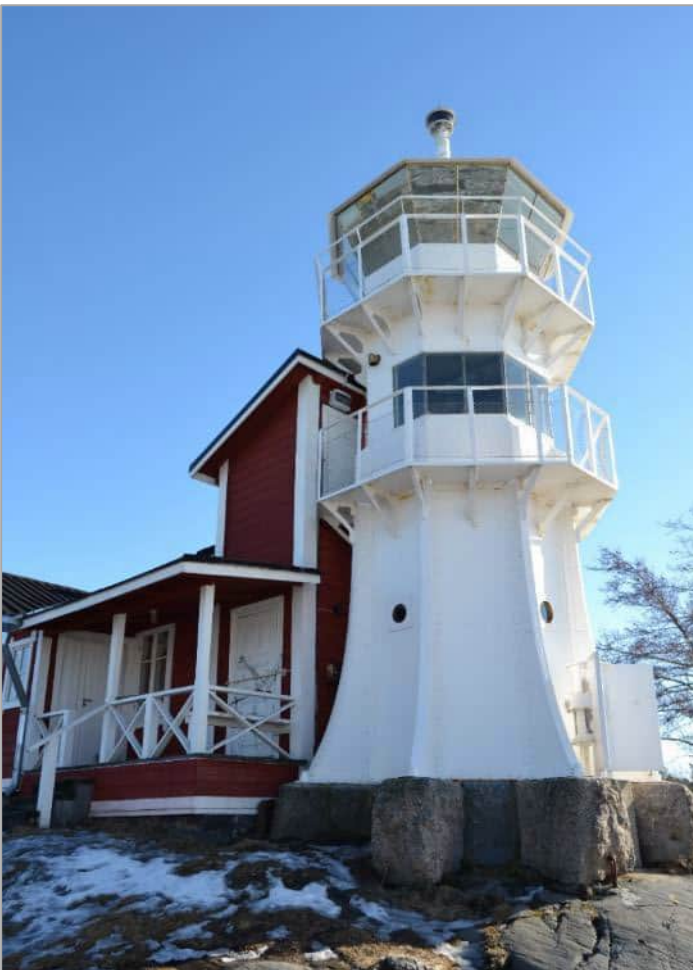
Kuva 26. Majakkatorni on kahdeksankulmainen. Kuvannut KT.
