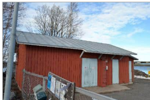
Kuva 53. Satama-alueella sijaitsee myös ulkoasultaan Meritaito Oy:n rakennuksen kanssa yhteneväinen varistorakennus. Kuvannut KT.
