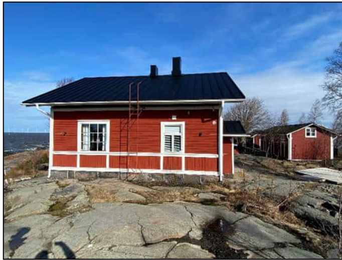
Kuva 21: Luotsivartiotupa sekä pihapiiriin kuuluvia talousrakennuksia.
