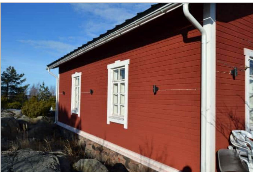
Kuva 36. Luotsivartiotupa kuvattuna länsisivulta. Kuvannut KT.
