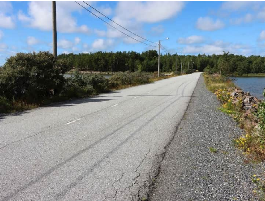
Kuva 1. Kalloa mantereeseen yhdistävä pengertie kuvattuna Mäntyluodon suunnasta.
