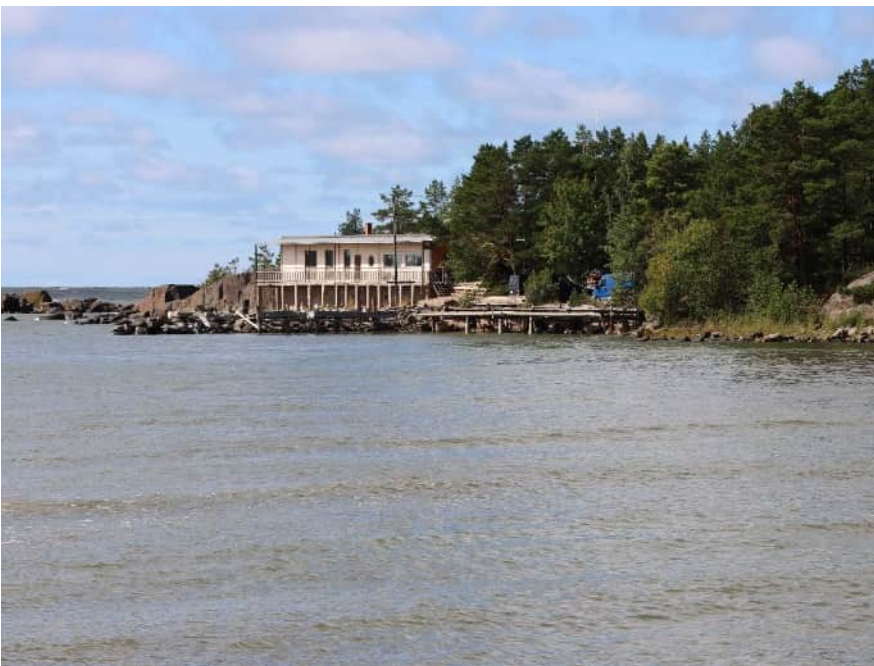
Kuva 10. Rakennus Mäntykallon itärannalla.
